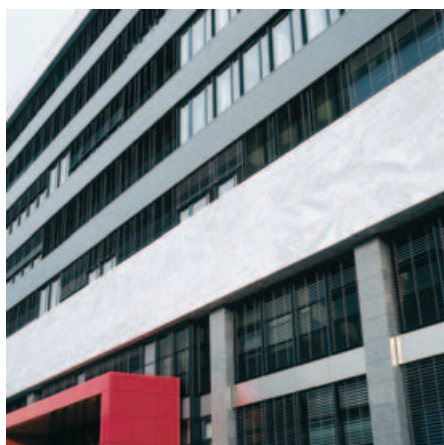
Rénovation de façade Landis + Gyr, Zoug
