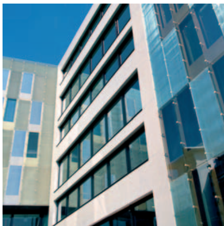
Habillage de façade en verre ABB Power Tower, Baden
