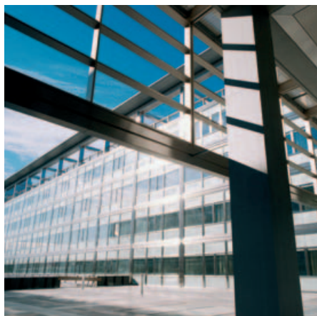
Façade par éléments avec stores intégrés ETH, Zurich Hönggerberg
