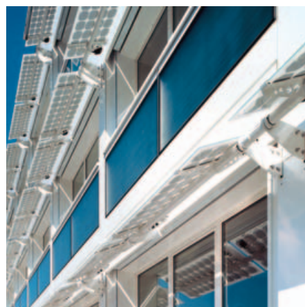
Façade énergétique Siège de l'Association des restaurateurs tessinois, Lugano
