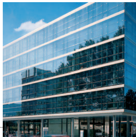
Façade double peau avec fenêtres bois/métal Fabrique de caisses, Zoug
