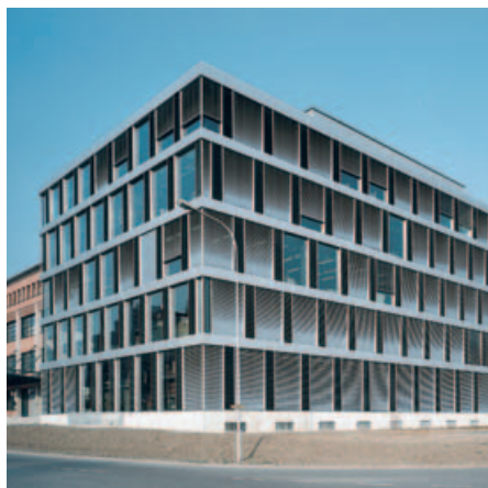
Façade par éléments Belimo, Hinwil
