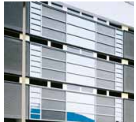
Cage d'escalier d'un immeuble d'habitation, Minusio
