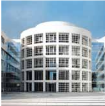
Bureaux et immeuble commercial Siemens, Renens
