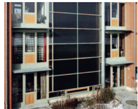
Energiefassade mit Sonnenkollektoren
