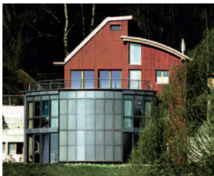
Façade énergétique en panneaux TWD
