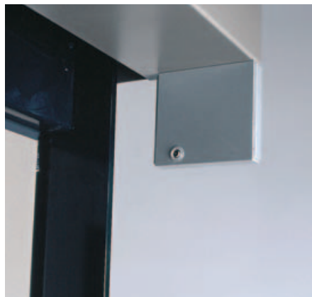
Lichtschranken Zur Kontrolle der Fluchtwegflügel beim Schiebebetrieb
