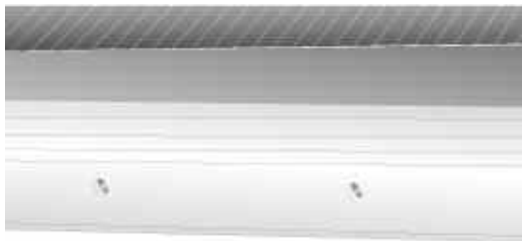
Bild 4-24: Bohrungen für den Potentialausgleich
