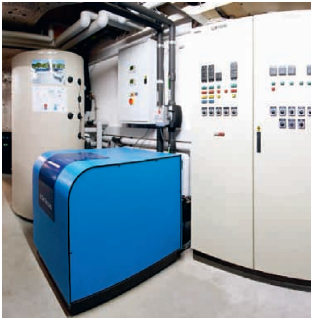
Machine réfrigérante à adsorption: elle rend la chaleur utilisable pour la production de froid
