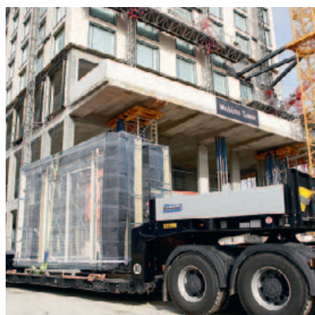
Fensterelemente für den Mobimo Tower: Von Schweizer produziert, just-in-time geliefert und montiert.
