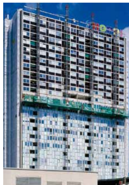
Shoppi-Hochhaus: stockwerkweise Sanierung mit Mastkletterbühne
