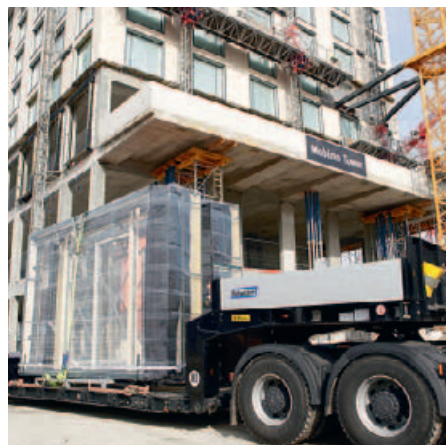
Eléments de fenêtres pour la Mobimo Tower: produits par Schweizer, livrés et montés just-in-time.
